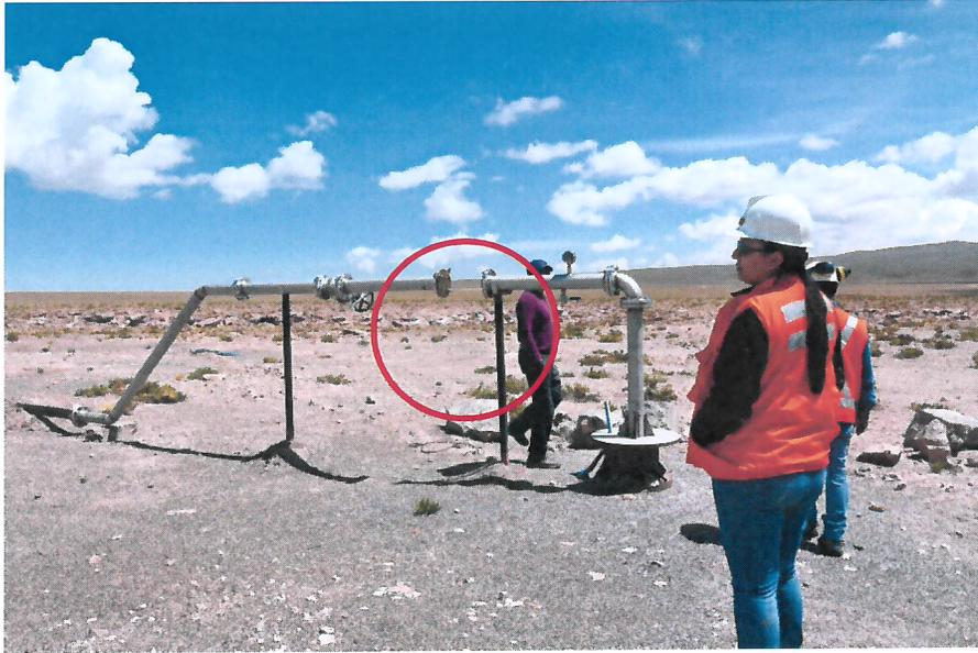
Fotografía 5. Sector de emplazamiento pozo 8B, se aprecia sistema de tuberías desconectado sin sistema de energización.
