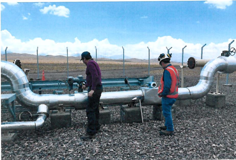
Fotografía 8. Sistema de tuberías y control de caudal pozo 9B.
