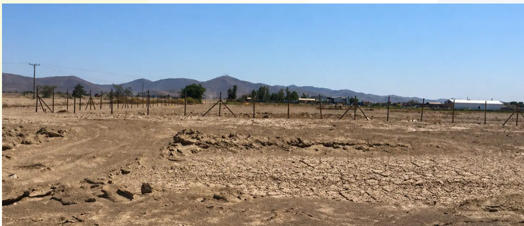
Proyecto “Parque Fotovoltaico Oxum del Tamarugal”, ubicado en la comuna de Pozo Almonte.
